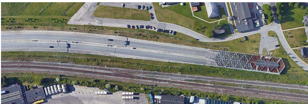
Figur 8-6 Nordhavnsvej – Vestlige portal fører hovedtunnelen til overfladen (Google Earth).
