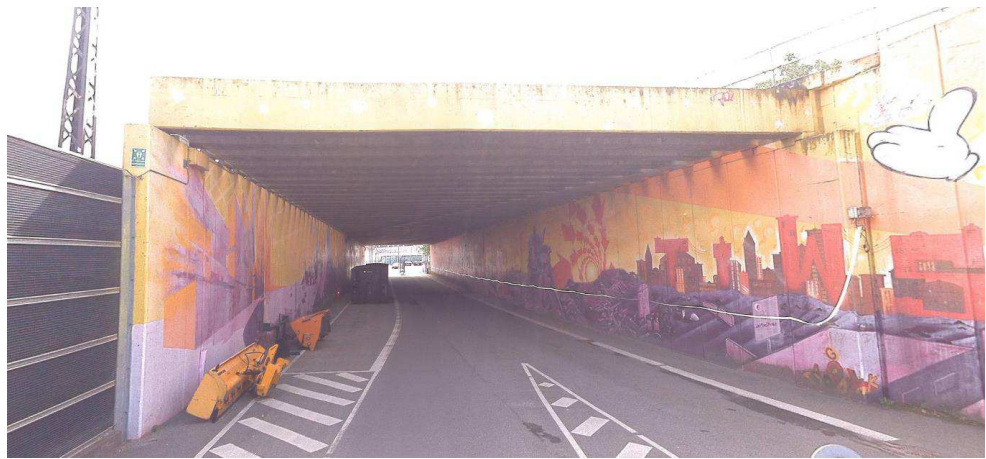
Figur 8-9 Bro 11640 fag 1 set fra vest mod øst. Her ses tydeligt de simpelt understøttede topbjælker der udgør understøtningen af Ringbanen.
