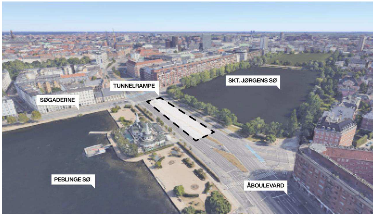
Figur 5-21 Rampe ved Sørerne
