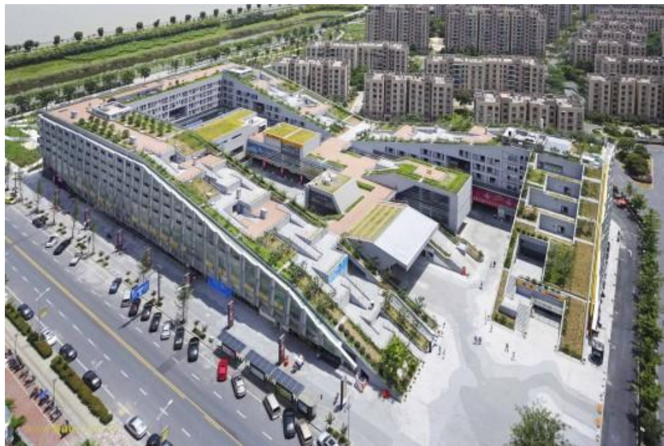
Billedet t.v. er et "mixed-use" projekt fra Hangzhou i Kina (15.700 m 2 boliger og 17.000 m 2 butikker og liberalt erhverv) og illustrerer et vellykket eksempel på et inviterende boligkompleks, med integrerede butikker og adgang til de grønne tage. Arkitekt: BAU Brearley Architects + Urbanists.
