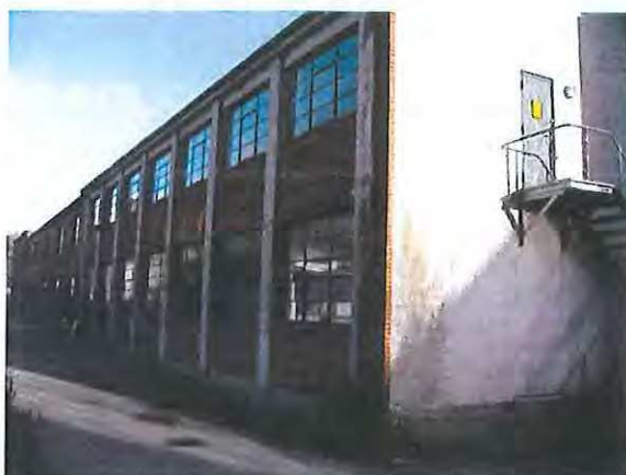
Nuværende facade af industribygning med fine sprossede vinduer mod det tilstødende lave beboelseskvarter.
