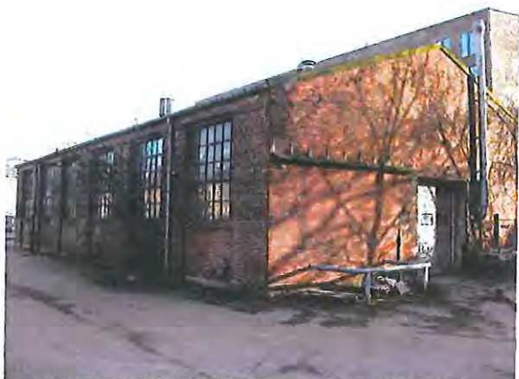
Fin klassisk industribygning, her skal der være 6 etager.
