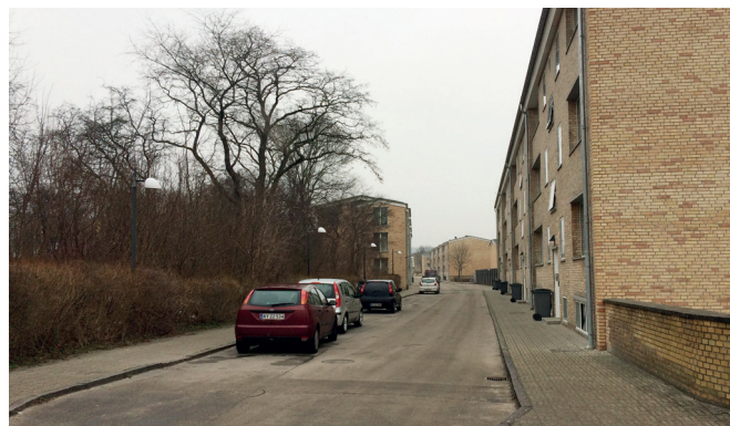
Kig ned af Bygårdsstræde mod nord, foto KK.
