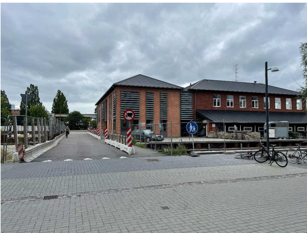
Foto 5 og 6: Midlertidig passage langs bagsiden af Københavns Roklub. Svarer omtrentligt til der, hvor Fiskerihavns-gade kommer til at ligge.
