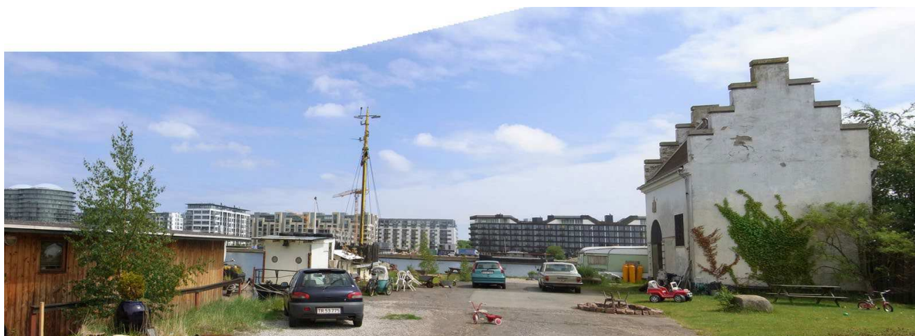
Den nordøstlige spids af Enghave Brygge med udsigt til Islands Brygge. Den hvide bygning, der bevares, anvendes til pumpestation.
