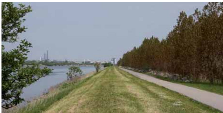
Figur 7.1 Promenaden langs Kalvebodløbet ind mod København. Den sydlige del af Kalvebod Miljøcenter ligger bag træerne til højre i billedet.
