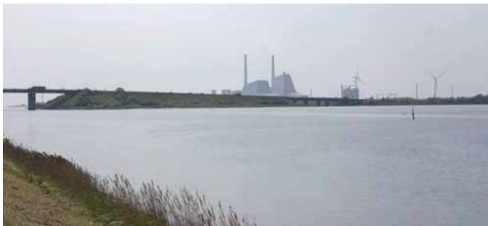
Figur 9.3 Kalvebodløbet set mod syd vest med udsigt til Amagermotorvejen, der krydser løbet til Skrædderholmen. Avedøreværket ses midt i billedet og til højre vindmøllerne på Avedøre Holme.
