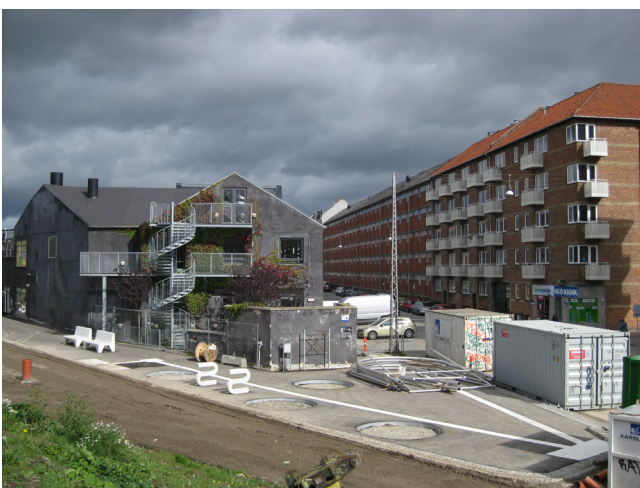
Hjørnet der ligger mellem Heimdalsgade og den nye "Superkilen"
