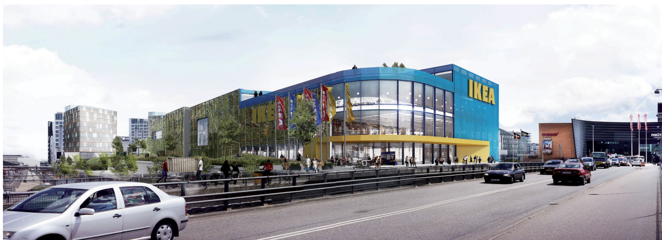
Visualisering der viser det nye IKEA-varehus og dets hovedindgang mod Dybbølsbro. I baggrunden ses Fisketorvet.
