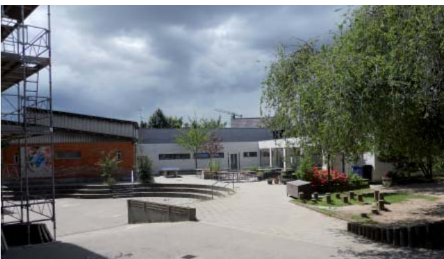
På vestsiden af skolen ligger en nyere tilbygning fra 1998, der rummer skolens nuværende fritidshjem. Uderummene rummer allerede i dag mulighed for forskellige aktiviteter.
