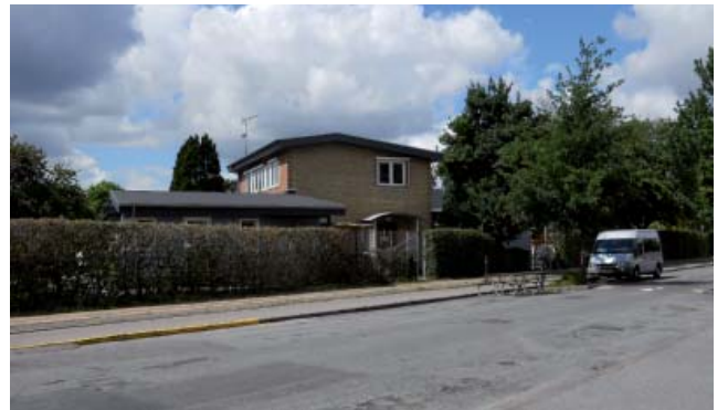
Den tidligere skoleinspektørbolig, der ligger ud mod Randbølvej, bruges i dag til fritidsklub. Bygningen er sløret af nyere tilbygninger, som dog vil kunne fjernes, så den bevaringsværdige bygning kommer til sin ret.
