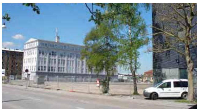
Bevaringsværdig bebyggelse Holmbladsgade 111
