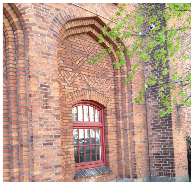
Eksisterende vinduesparti mod Thorsgade
