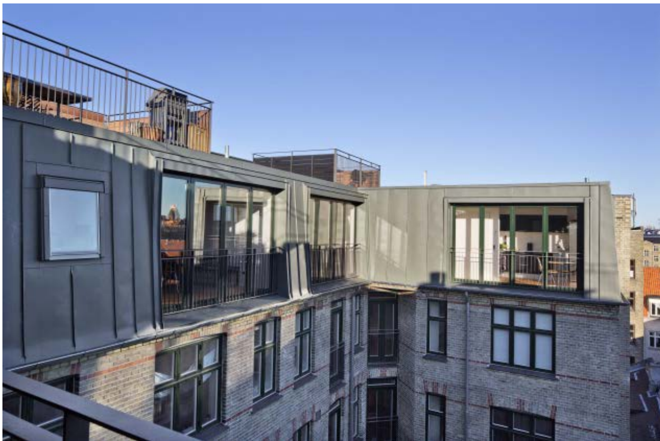
Rejst tagflade mod gård. Zinkbeklædt tagflade og kviste. Stålværn ved franske altaner, tagterrasser mv.
