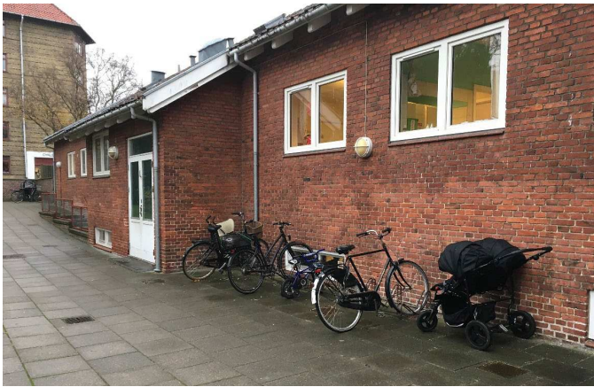
Billede fra daginstitutionens ankomstareal med bygningen, som nedrives.
