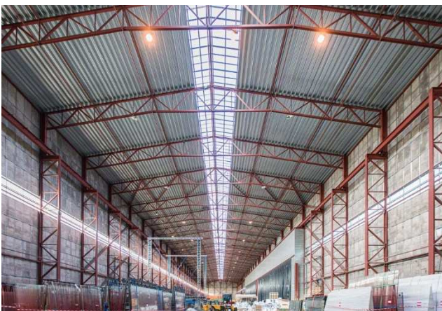
1.5 Eksisterende stålstruktur og ovenlys i Armeringshallen.
