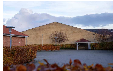
Jorisvej 11a – Gavl fra fabrikshal opført i 1969.
