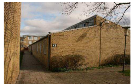
Institutionsbygninger i 1 etage og med forskudte tage
