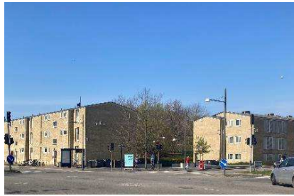
Nuværende facade på Åkandevej, set mod syd/vest.
