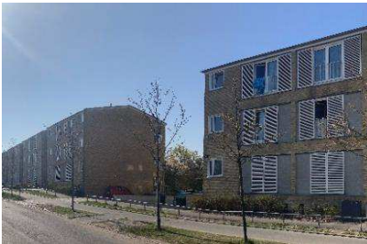
Facade med ny tagetage på Ruten, set mod syd/øst.
