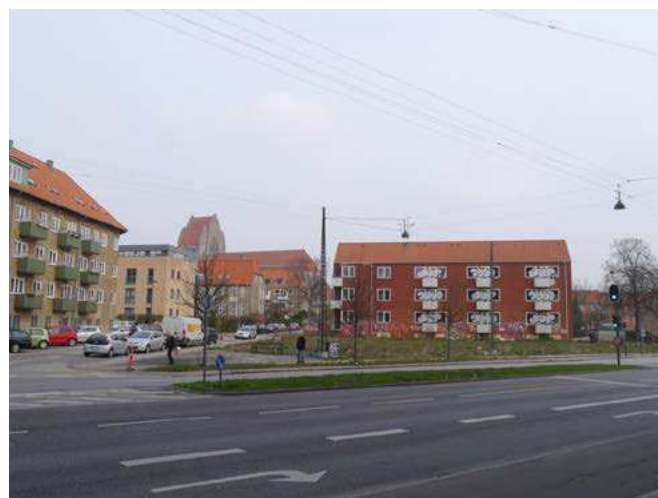
Byggegrunden set fra Tuborgvej. Den eksisterende bygning Journalistgården er tilladt nedrevet. Foto: Vilhelm Lauritzen Arkitekter
