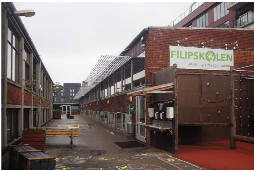
Amager Strandvej 124 bygning 1 og 3 set fra øst.
