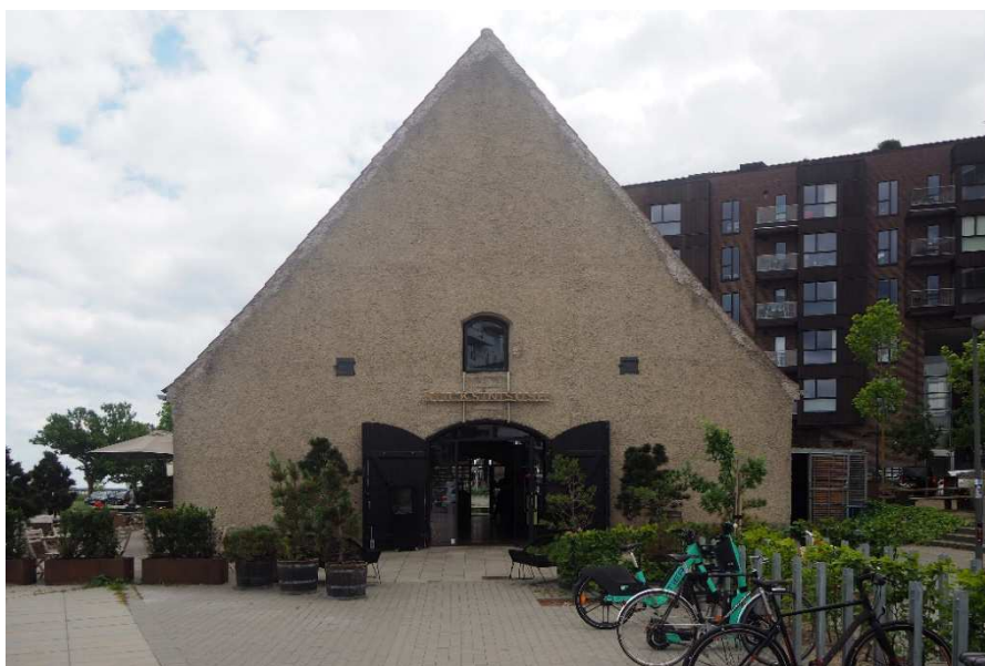
Amager Strandvej 110, nordgavl.
