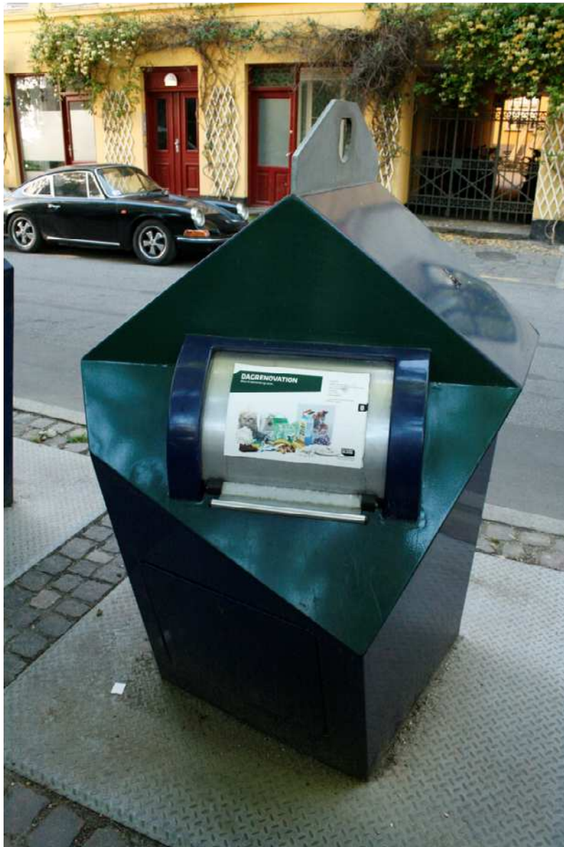
Figur 4.12 Dagrenovation indkast søjle.
