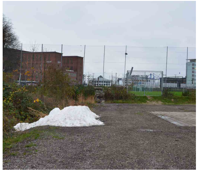
Områdets nordlige afgrænsning med Svanemølleværket i baggrunden
