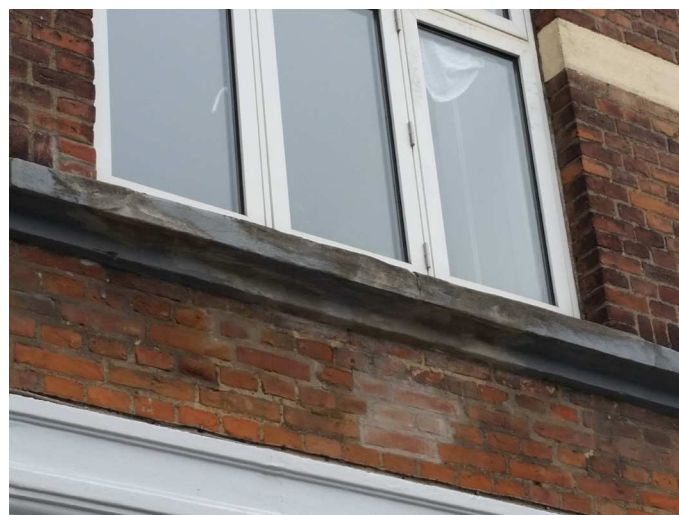
Nedslidt facade og sålbænk.
