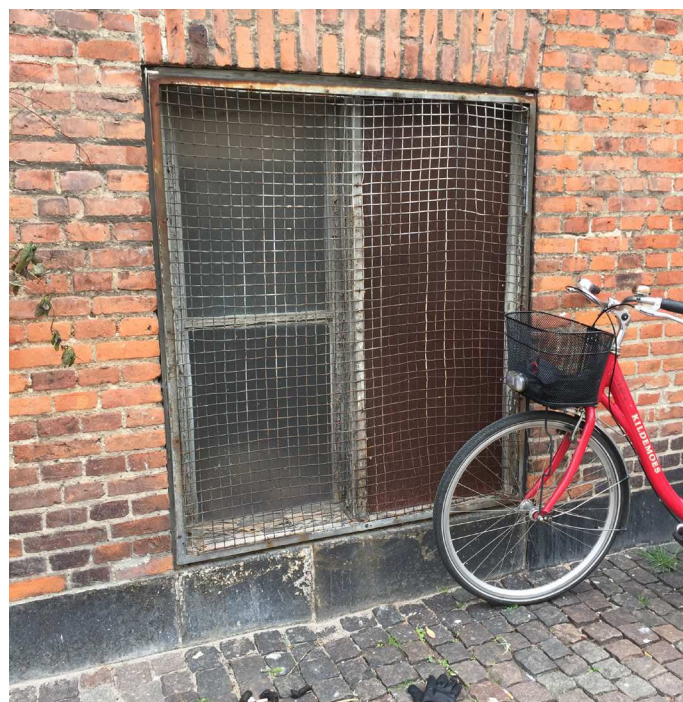
Kældervinduer er originale etlagsvinduer, der er nedslidte.
