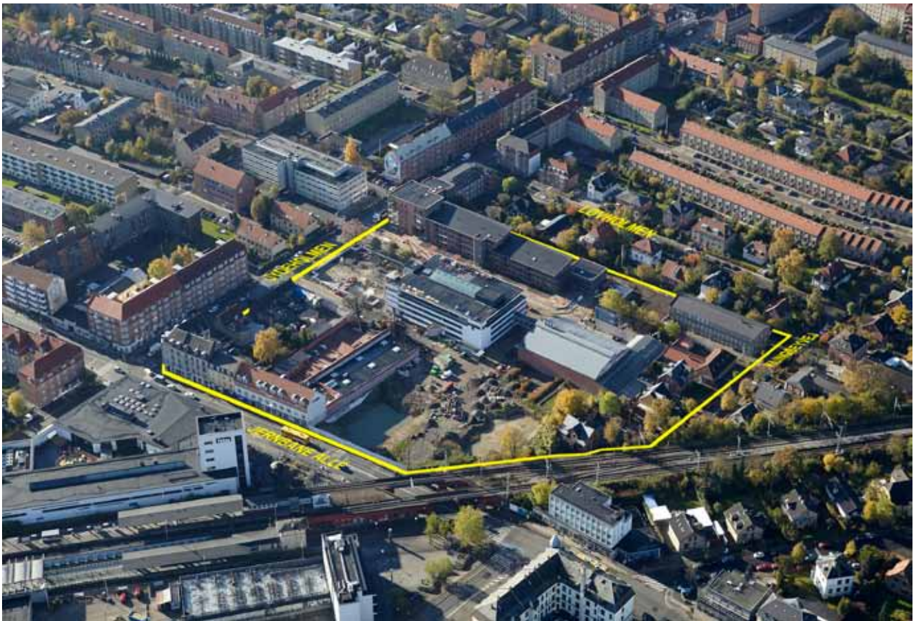
Luftfoto af planområdet og dets omgivelser set fra nordøst (JW Luftfoto oktober 2010).
