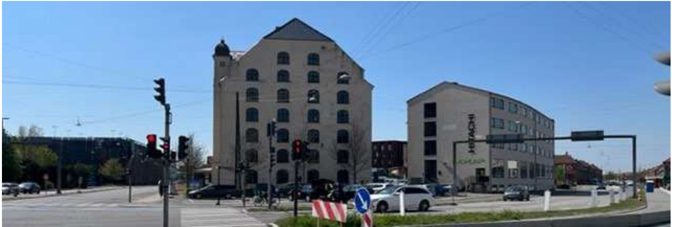
Billede af pakhuses gavl set fra nord. Vejen højre om pakhuset er Sydhavns Plads og vejen venstre om pakhuset er Scandiagade.
