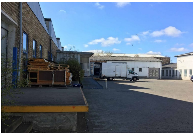
Eksisterende industribygninger set fra nord - bygningerne nedrives. Foto: Skovhus Arkitekter.
