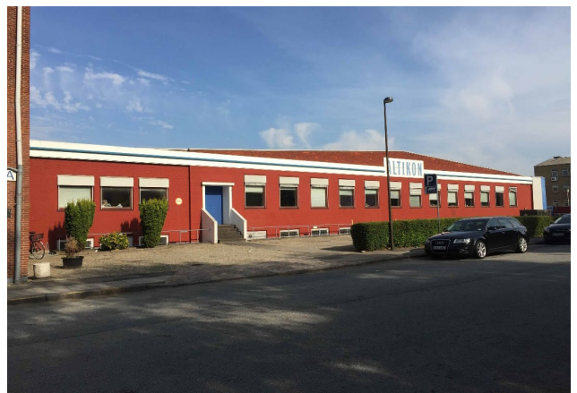
Kobbelvænget 72 set fra sydøst - bygningen nedrives. Foto: Skovhus Arkitekter.
