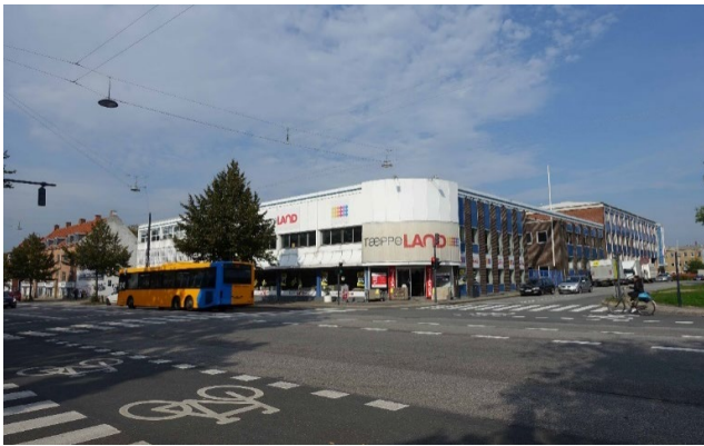
Hjørnet af Frederikssundsvej/Kobbelvænget set fra sydøst - bygningerne bevares. Foto: Skovhus Arkitekter.
