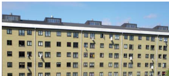
De eksisterende facader mod øst.
