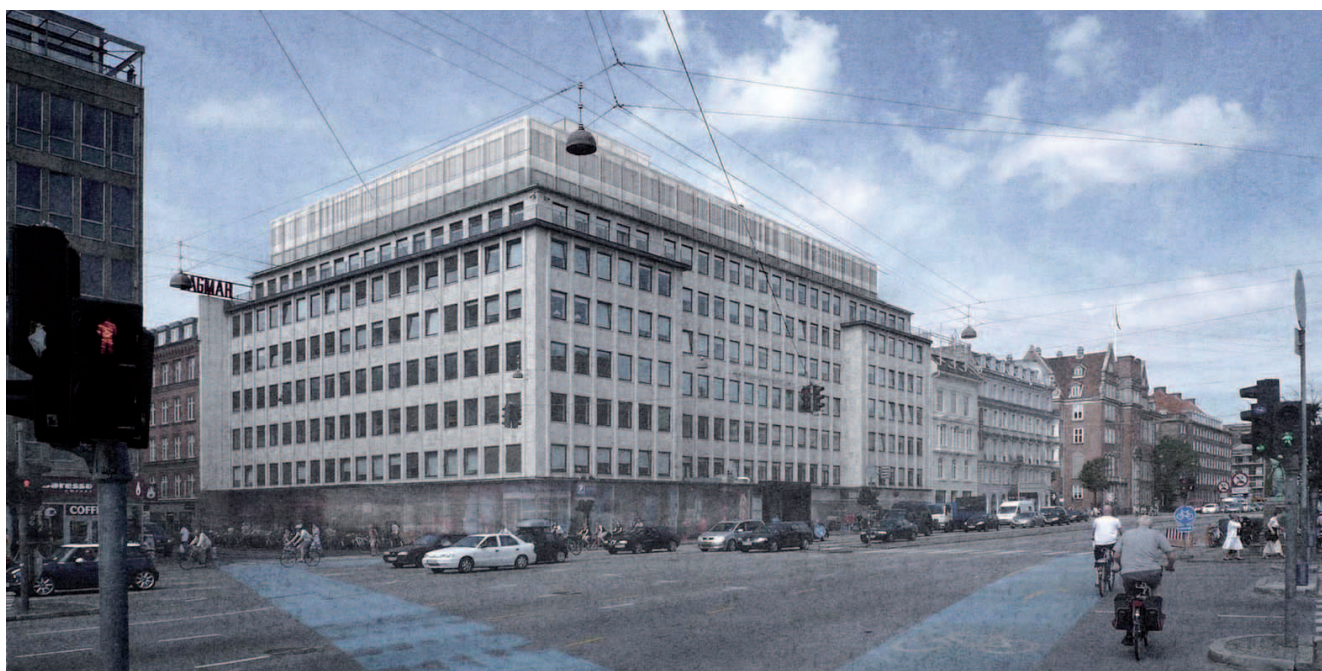
Visualisering set fra det nærmeste hjørne af Rådhuspladsen. Illustration af Steenberg Architects.
