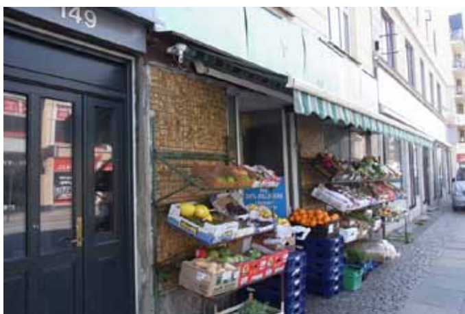
Udsnit af underfacade mod Amagerbrogade
