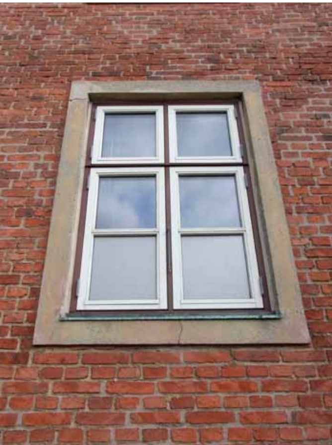
Vindue med indfatning
