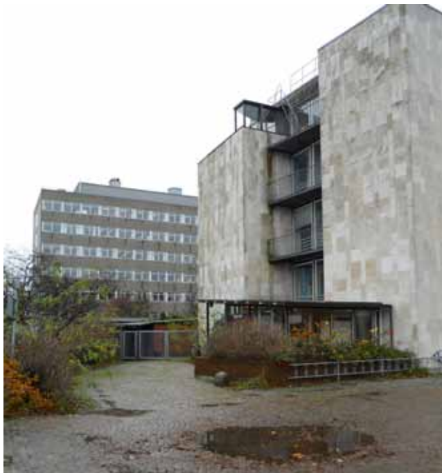
Det Farmaceutiske Fakultet set fra Nørre Allé med byggefeltet mellem Bygning 17 forrest og Bygning 13 bagerst.
