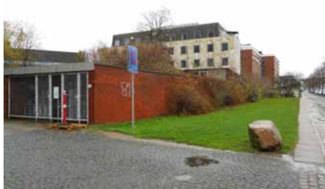
Byggefeltet set fra Nørre Allé med Bygning 17 bagerst. De lave bygninger forrest skal nedrives.
