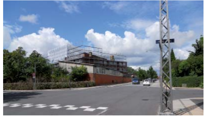
Skolen set fra krydset Vanløse Allé/Randbølvej. I forgrunden ses den ene af skolens to gymnastiksale, der ligesom den anden er beklædt med bølgeterniplader på den øverste del af facaden
