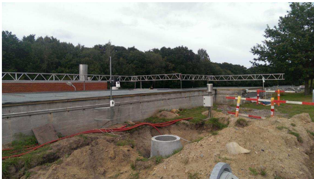
Billede 2 Opbygningen med den ene af de to brønde, som indeholder en flowmåler til bestemmelse af vand flowet fra taget
