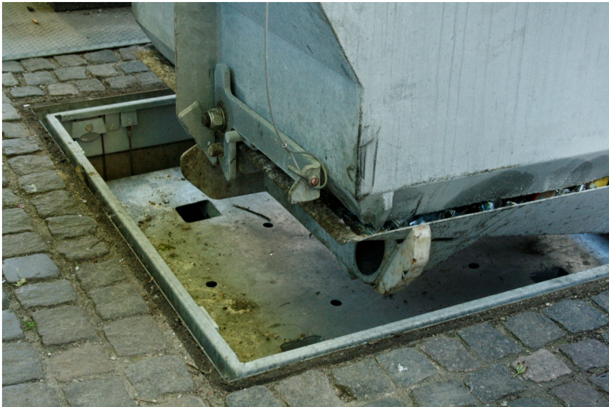
Figur 4.11 Faldsikringen kører ikke helt op til niveau, men stopper 20 cm under terræn. Derudover ses den monterede udløsermekanisme, i form af en wire, på anslagsarmen.
