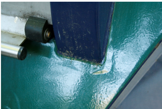
Figur 4.13 Formodt korrosion.
