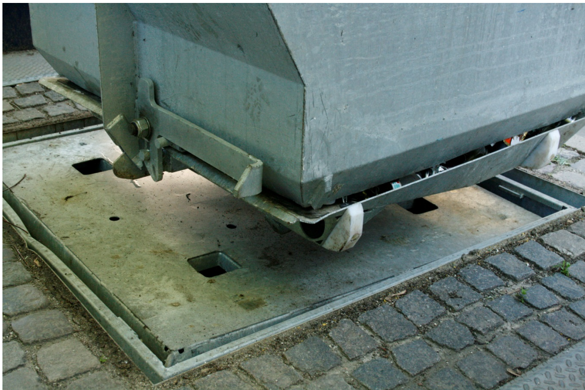
Figur 4.10 Faldsikringen kører kun med besvær op til næsten det niveau, hvor den bør stoppe og ligger dernæst skævt.
