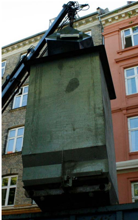
Figur 4.2 Den nedgravede beholder, som den ser ud løftet fri af betonkummen.
