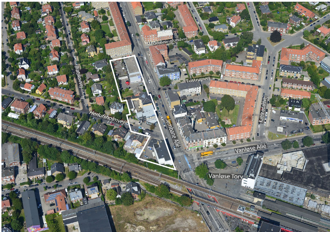
Luftfoto af lokalplanområdet set fra syd
