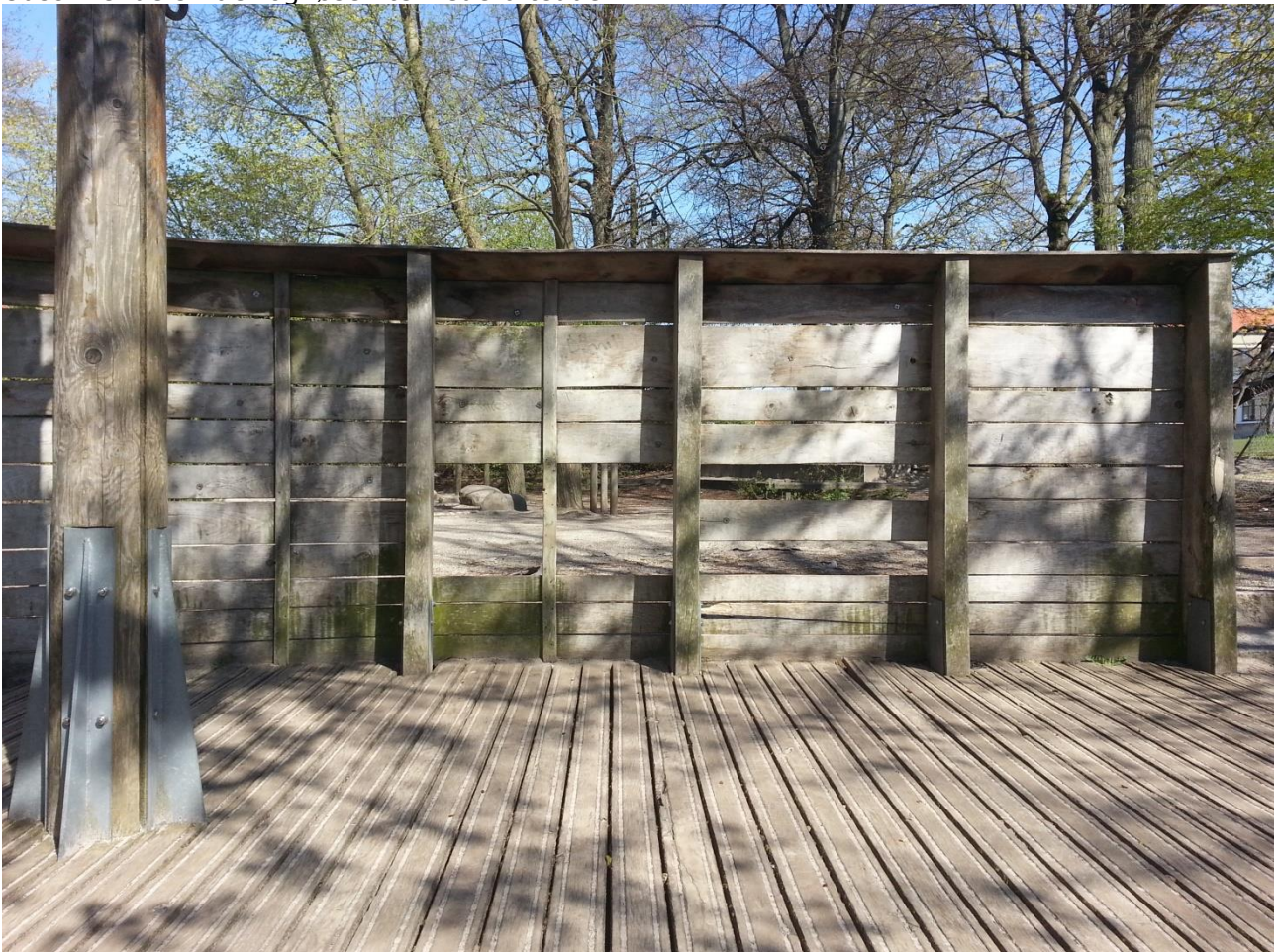
Udstikkende skruer og løse flækkede brædder
