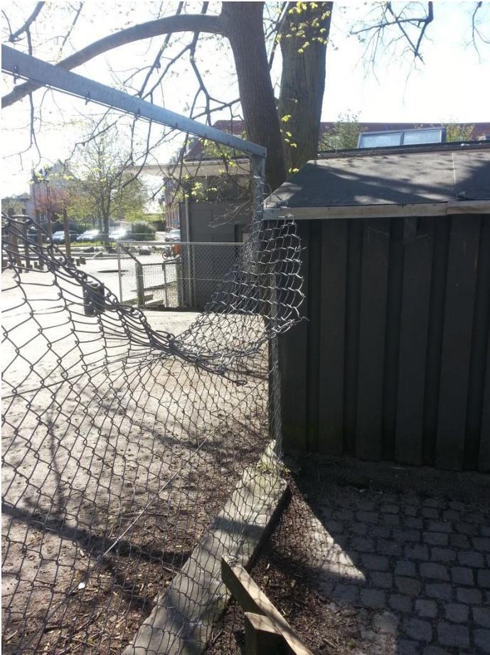
Endnu et trådhegn med løse wirer i øjenhøjde
