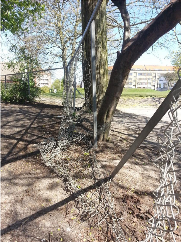
Trådhegn med udstikkende wirer i øjenhøjde
