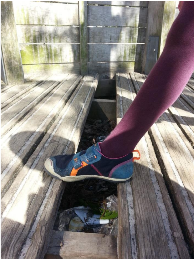
Manglende planker i underlag der lige passer til en børnefod
