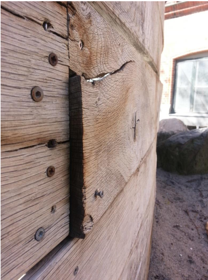
Udstikkende skruer og løse flækkede brædder
