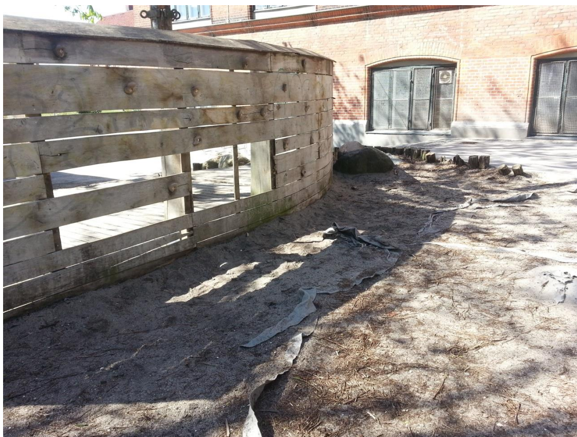
Huller og løse planker i klatrevæg
