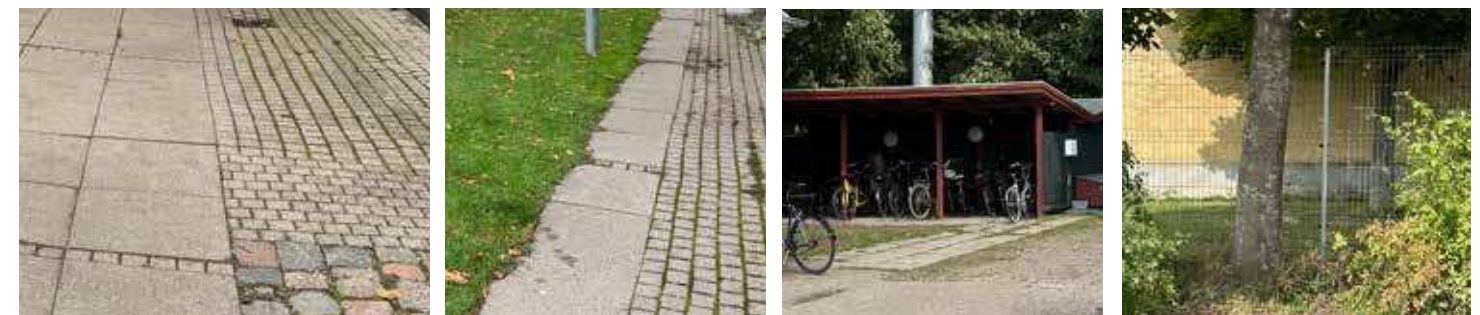
Eksisterende forhold: betonfliser og granit (genanvendes), cykelskur (ombygges til renovation), hegn nedtages til genbrug
