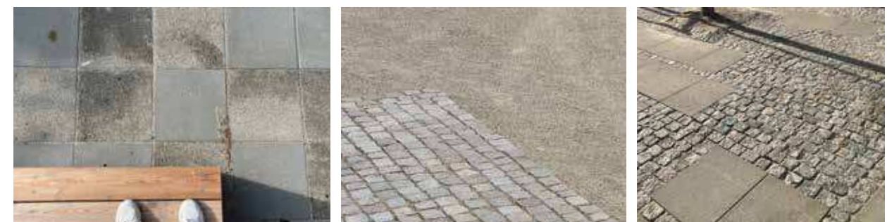
Eksempel på genanvendt beton iblandet nye fliser, på chausséen og grus og på blanding af materialer
