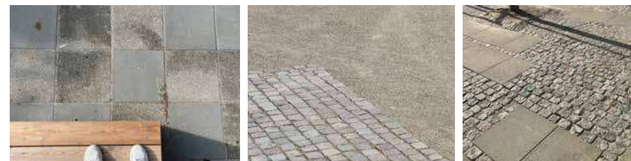
Eksempel på genanvendt beton iblandet nye fliser, på chausséen og grus og på blanding af materialer
