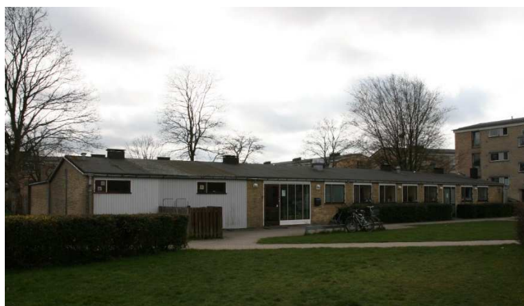
Den fritliggende fløj set fra nord
