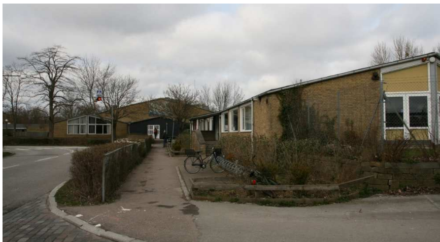
Bygningsanlægget set fra syd Terrasserne med gavlenderne af de to hovedfløje.
