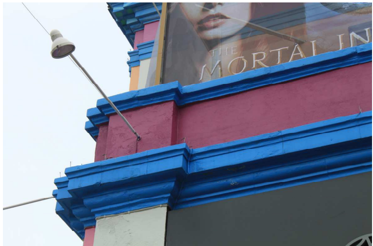
Belysningsstander på facade
