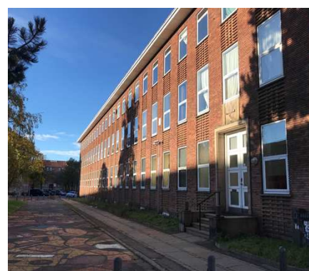
Tidligere General Motors administrationsbygning, der udpeges som bevaringsværdig, set fra Vermundsgade.
