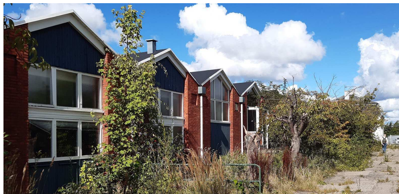
Den bevaringsværdige fabriksbygning facade med en fast takt af gavlmotiver. Til højre ses Fabriksgaden, der er en central akse på grunden, og strækker sig fra Slotsherrensvej til skel mod syd. Træerne langs gaden har været et markant element, men er ikke bevaringsværdige. Lokalplanen sikrer, at der plantes en ny markant træstruktur.
