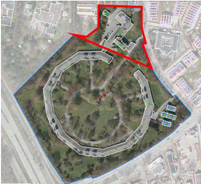
Figur 1: Ringbo fra luften. Den cirkelformede del af bygningen planlægges nedrevet. Med rødt markeret den del af ejendommen som ikke planlægges overtaget af Gladsaxe kommune. Mod sydøst desuden 3 bygninger, der ikke planlægges nedrevet.
