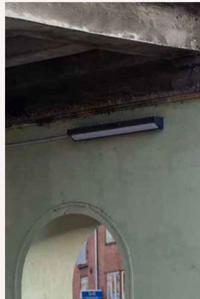
Påbygget armatur: Fagerhult 'Tuscan' - vinklet profil
