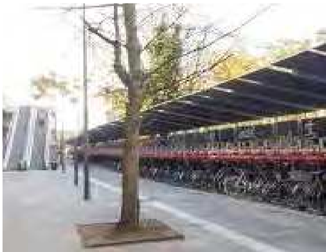
Nørrebro Station - Cykelstativer
