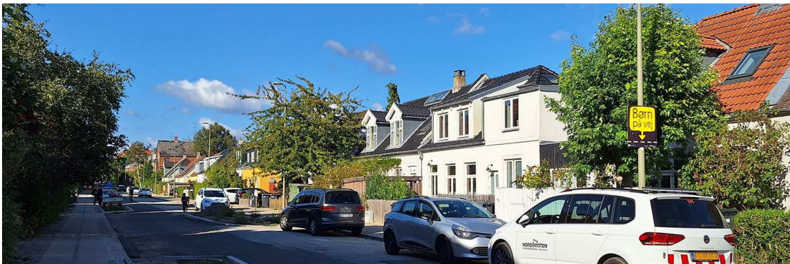
Trekronergade set fra syd med byggeforeningshuse i 1 ½ etage.
