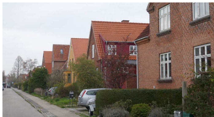
Strindbergsvej set fra syd karakteriseret ved ens facadeflugt og røde tegltage.
