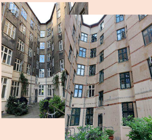
FØR/EFTER: Renovering af gårdfacade og udskiftning af vinduer (Stefansgade 18-22 mfl.)
