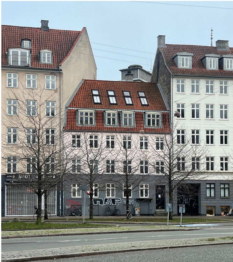
Bygningens facade, set fra Nørre Voldgade.
