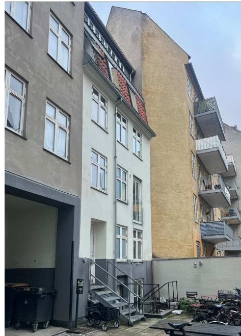
Bygningens facade i sammenhæng med nabofacader, set fra gårdrummet.
