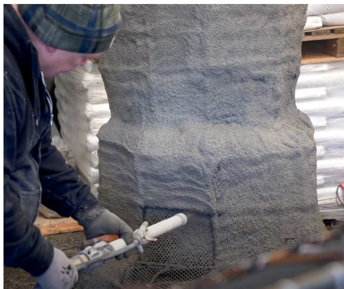
Eksempler på makemake specialbeton over stålarmaturkonstruktion og støbt punktforankring.
