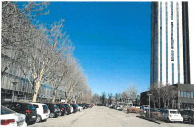
Lokalplanområdet mod Amager Boulevard
