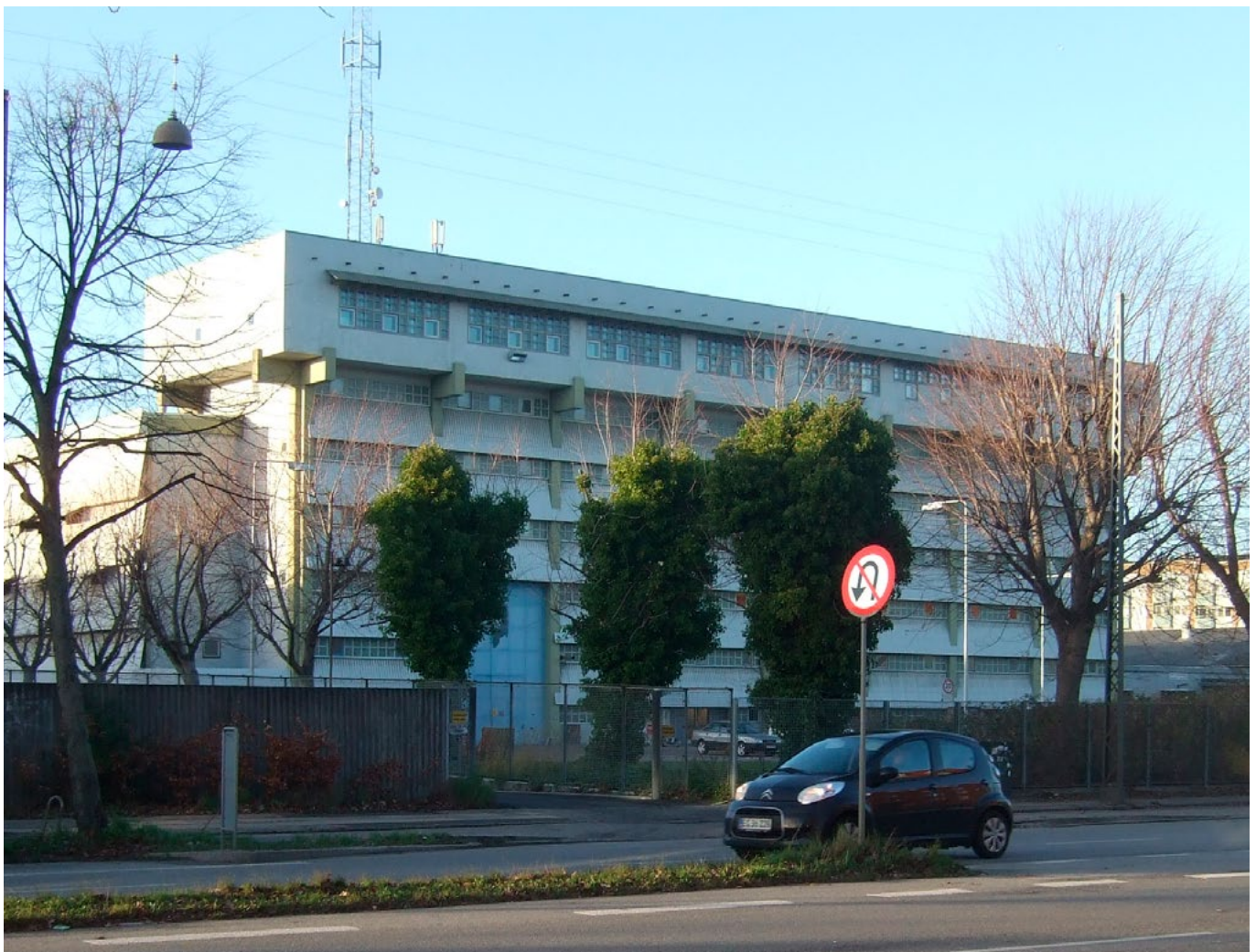
Hovedbygningen til Bellahøj Koblingsstation
